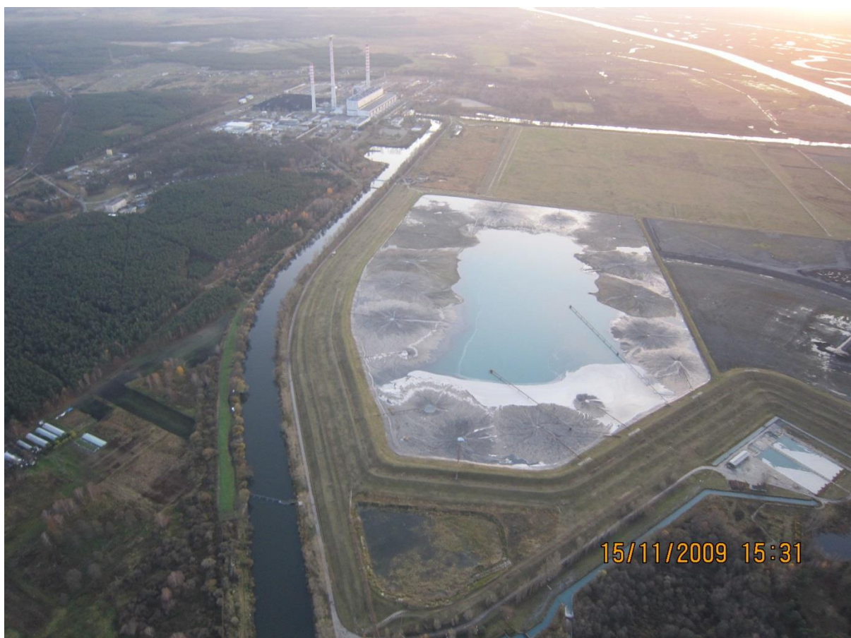
Zdjęcie 47. Kanał Ciepły przy Elektrowni Dolna Odra
